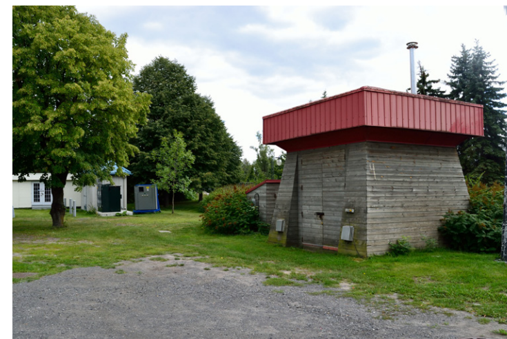
Bâtiment technique, secteur chez Tommy, Jonathan Cha, 2016.
