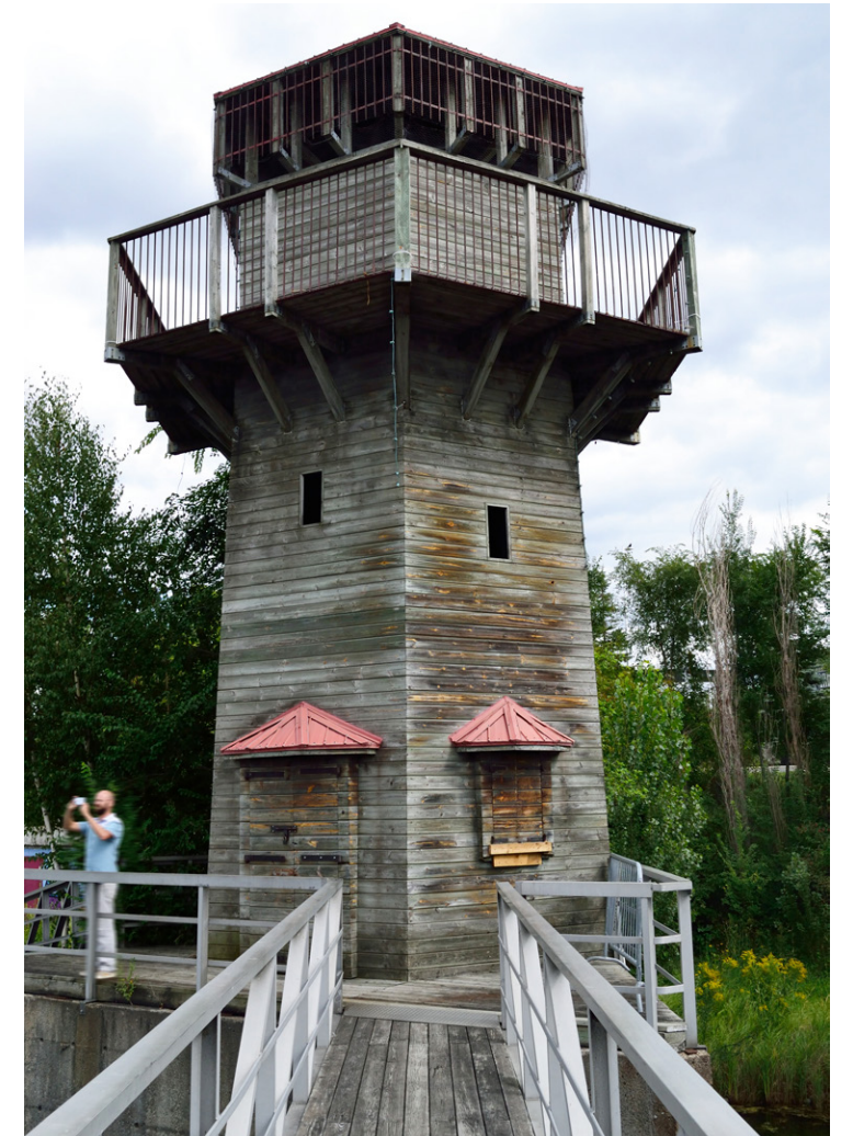
Phare no-1 et passerelle, Jonathan Cha, 2016.
