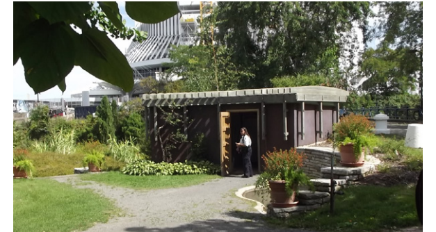
SOUS-STATION ÉLECTRIQUE (T29) | date: 1979
