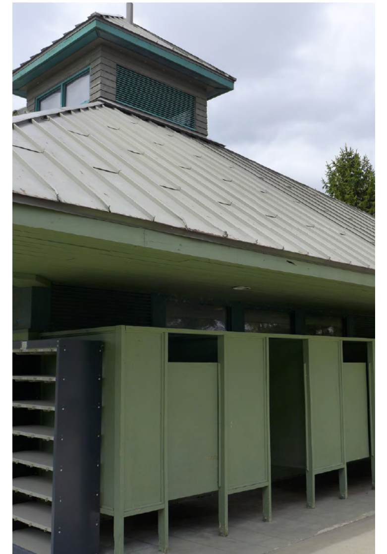
Bloc sanitaire, Jonathan Cha, 2016.
