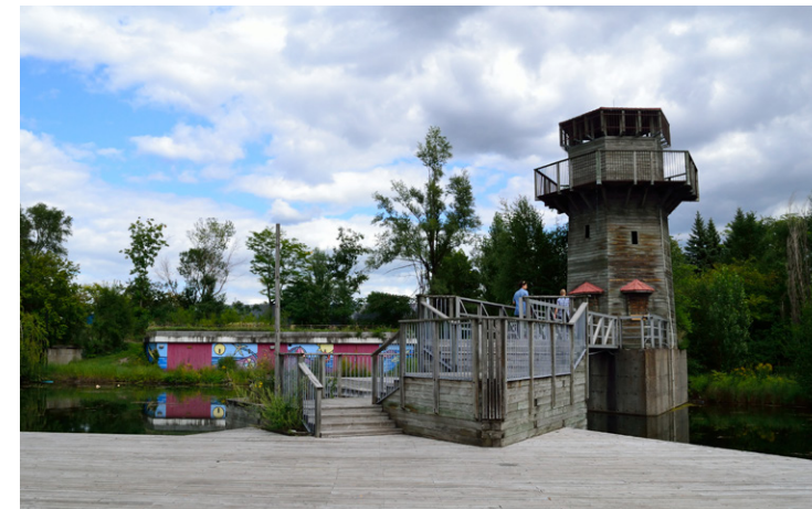
Phare no-1 et passerelle, Jonathan Cha, 2016.
